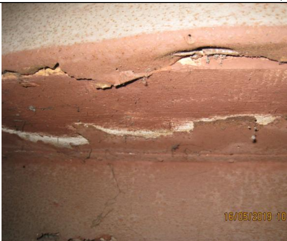
Фото12 Состояние лестницы со стороны подступенков, провал досок на площадке
