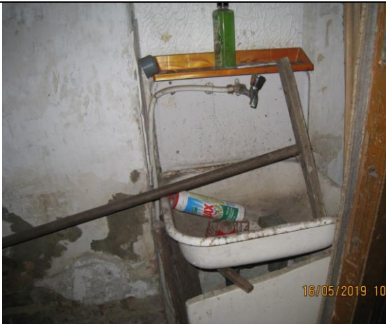
Фото15 Отслоение обоев, грибок, увлажнение внутренних стен, сырость в квартире №4
