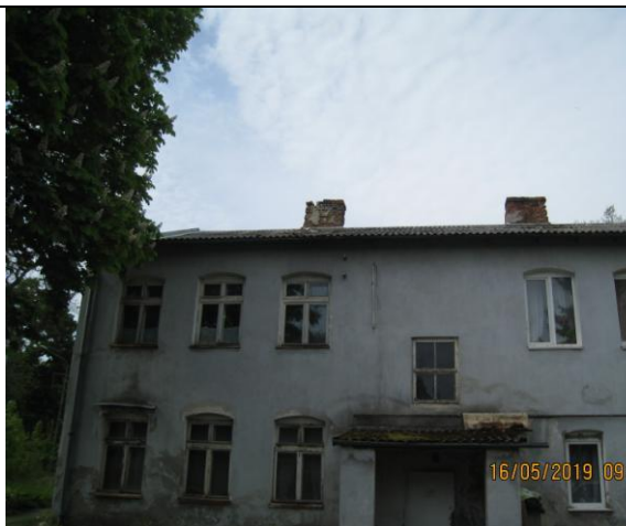
Фото9 Состояние кровли и дымоходов над кровлей, разрушение кладки
