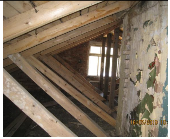
Фото18.Состояние стропильной системы после реконструкции в 1997г
