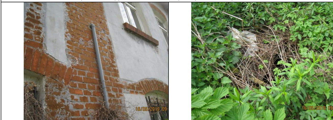
Фото6 Искривление линии цоколя, разрушение кирпичного фундамента под действием влаги
