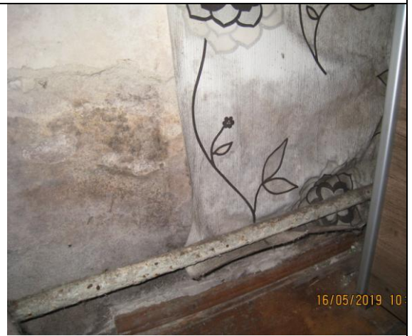
Фото15 Отслоение обоев, грибок, увлажнение внутренних стен, сырость в квартире №4
