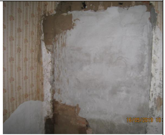
Фото15 Отслоение обоев, грибок, увлажнение внутренних стен, сырость в квартире №4
