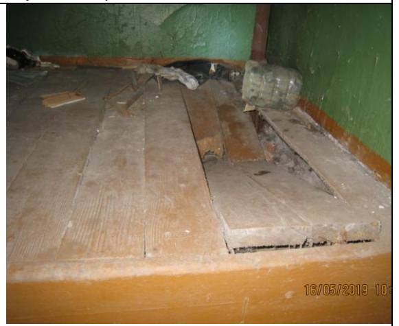
Фото12 Состояние лестницы со стороны подступенков, провал досок на площадке
