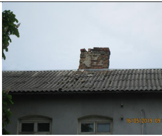
Фото9 Состояние кровли и дымоходов над кровлей, разрушение кладки
