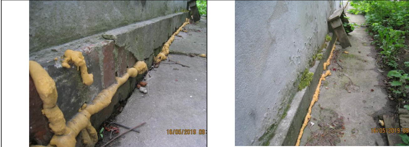
Фото6 Искривление линии цоколя, разрушение кирпичного фундамента под действием влаги
