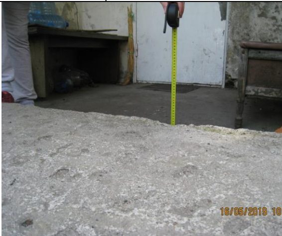
Фото12 Состояние лестницы со стороны подступенков, провал досок на площадке
