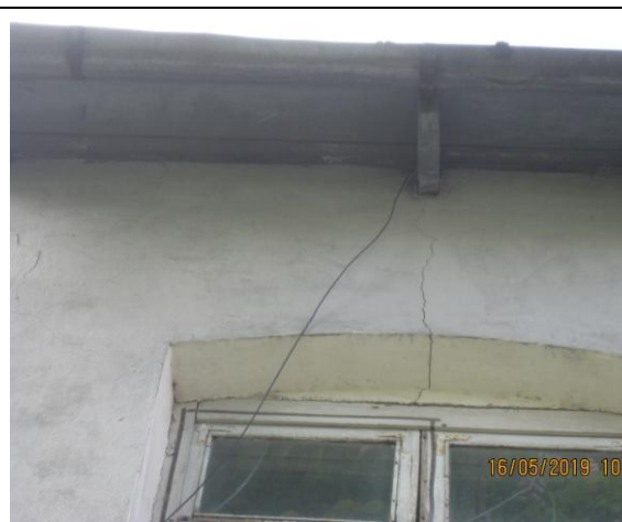
Фото 21 Трещины на стенах здания на 1-ом и 2-ом этажах
