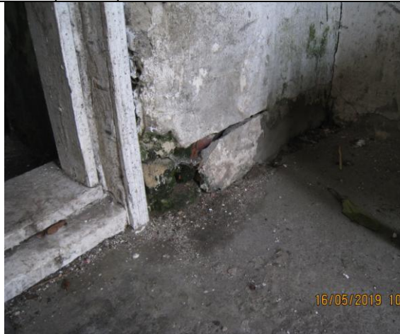
Фото 21 Трещины на стенах здания на 1-ом и 2-ом этажах
