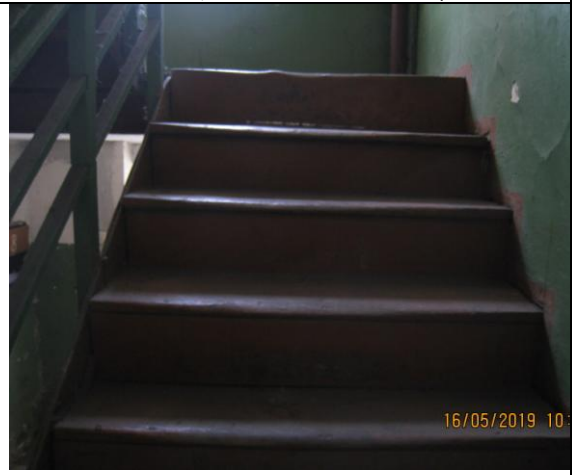
Фото12 Состояние лестницы со стороны подступенков, провал досок на площадке
