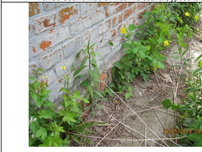
Фото3 Состояние отмостки здания, уровень пола в помещениях 1-ого этажа ниже отметки земли
