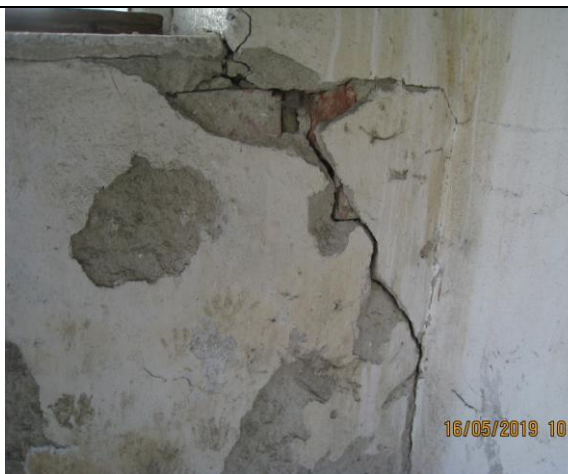
Фото 21 Трещины на стенах здания на 1-ом и 2-ом этажах
