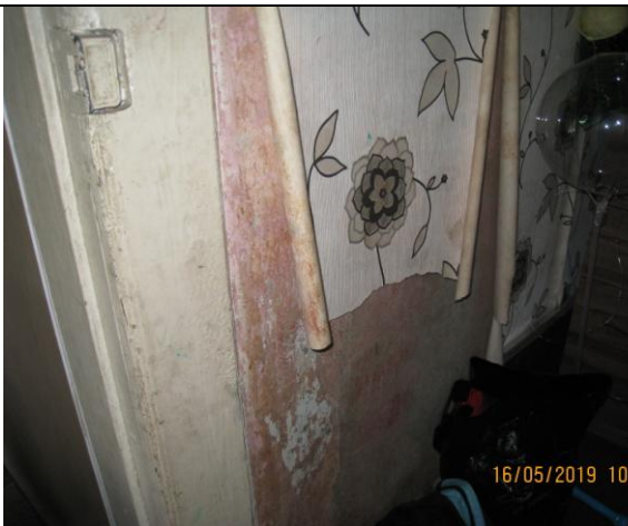
Фото15 Отслоение обоев, грибок, увлажнение внутренних стен, сырость в квартире №4
