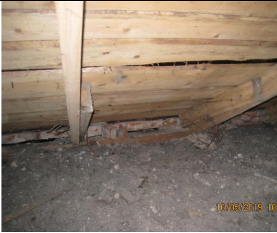
Фото18.Состояние стропильной системы после реконструкции в 1997г
